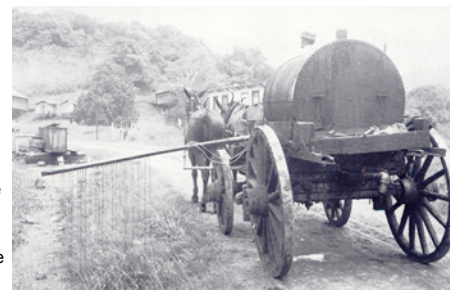
Cubriendo una zanja con insecticida. Crédito: Ulrich Keller, The Building of the Panama Canal in Historic Photographs , Nueva York: Dover, 1983, pág. 12.
