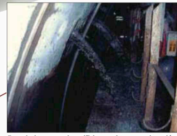
Entrada de agua por los orificios previstos para el trasdós.
