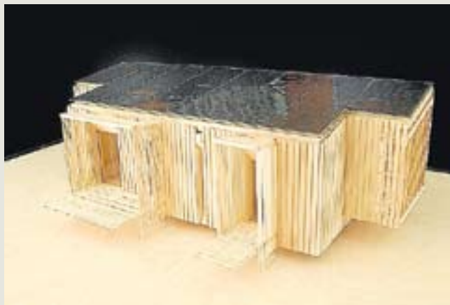
> UNIVERSIDAD DE TECNOLOGÍA DE HELSINKI (FINLANDIA) - 'LUUKKU' Incluye paneles fotovoltaicos y agua caliente con colectores solares. El material de las paredes interiores se utiliza para almacenar calor, con productos para el control de la humedad.
