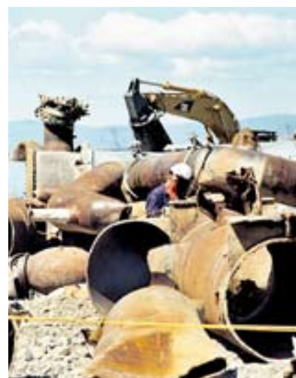
Trabajadores durante la demolición
