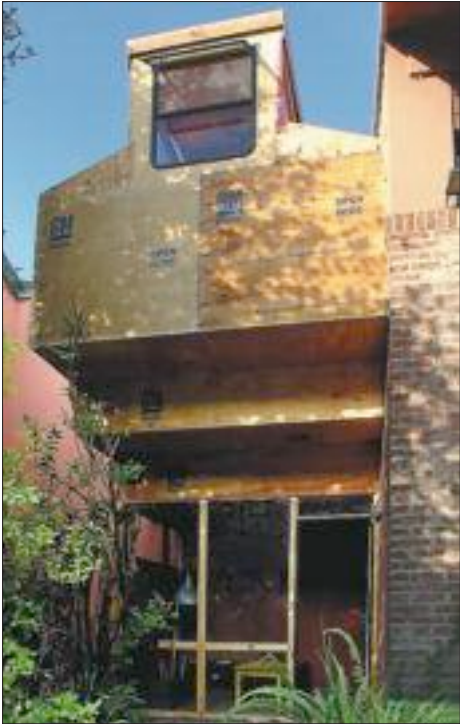
Ampliación de una vivienda con contenedores de madera, del estudio argentino A77.
