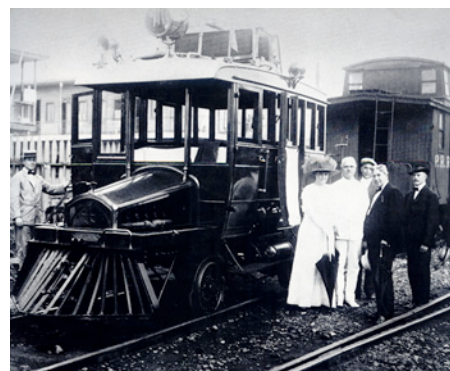
El Coronel Goethals y su esposa junto al Panama Canal Car No.4, vehículo usado para realizar las inspecciones de las obras en el Canal y conocido como "el peligro amarillo" a causa del color de su techo. Crédito: Ulrich Keller, The Building of the Panama Canal in Historic Photographs , Nueva York: Dover, 1983, pág. 51.
